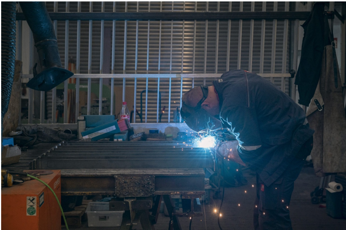
Die Funken fliegen: Hier entsteht ein Metallgerüst. Carlotta Steinkamp
