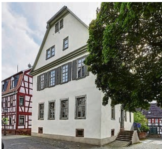
Ausgezeichnete Arbeit: das denkmalgerecht sanierte ehemalige reformierte Pfarrhaus in der Windecker Altstadt.
